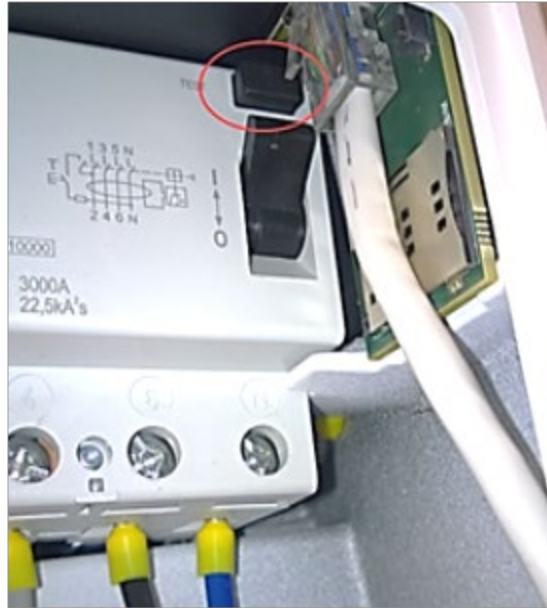
Figura 42: Botão de teste de RCD
